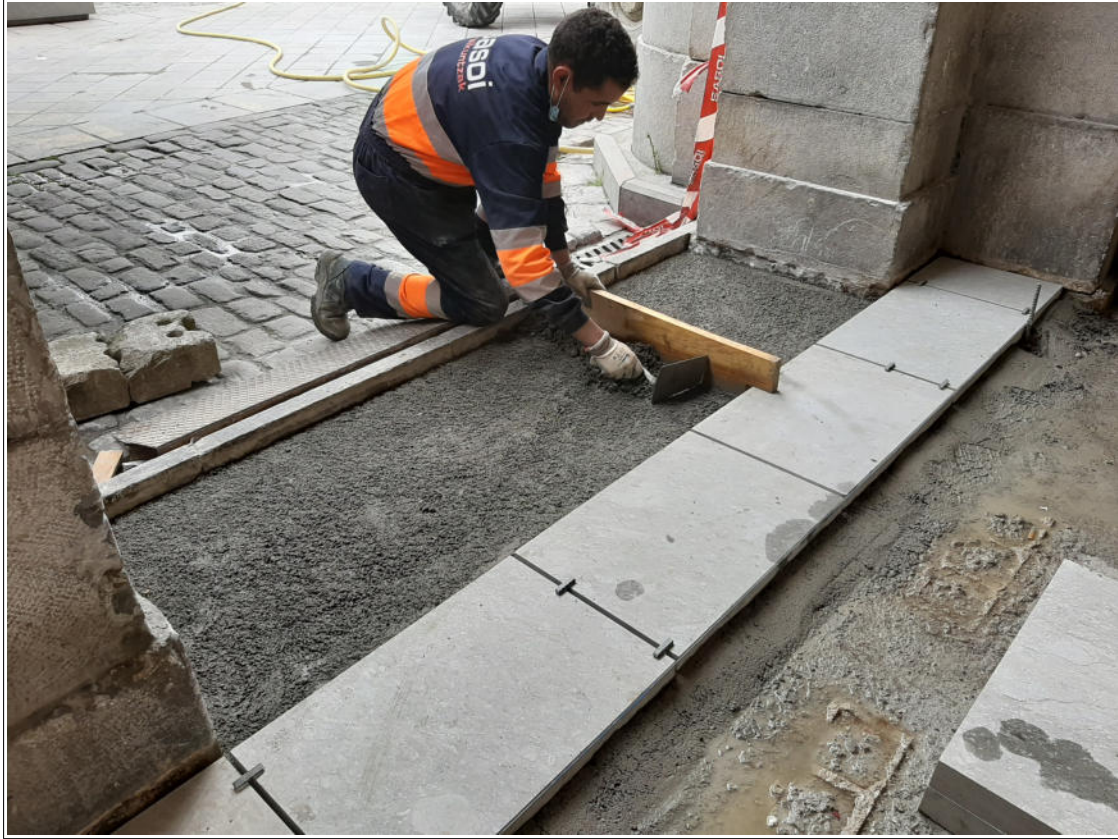
Tina harlauzazko zoladuraren exekuzioa (2021-05-13)
