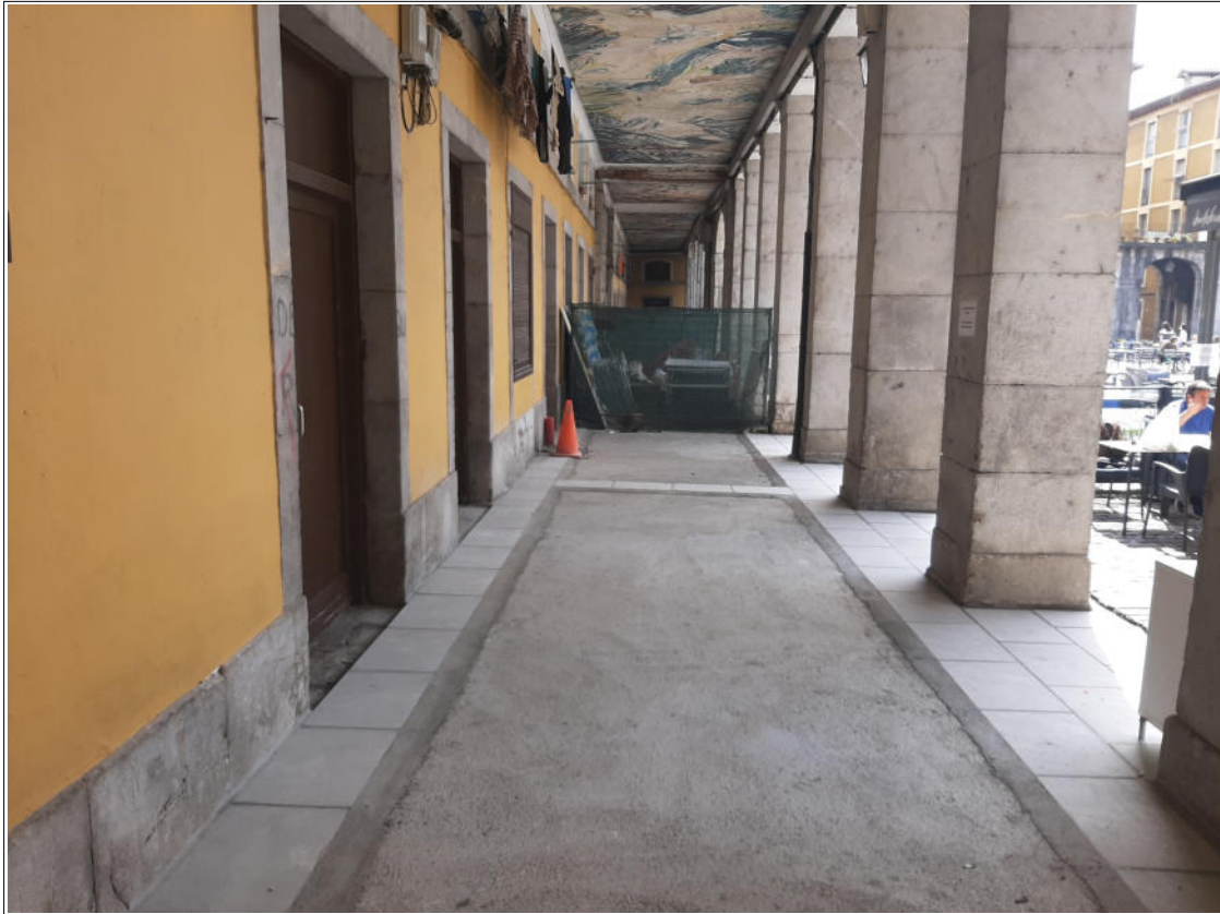
Harlauza zenefatan eta asfalto funditurako hormigoizko oinarria (2021-05-28)
