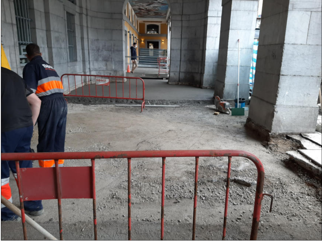
Bide zoladuraren oinarria. Zagorra eta hormigoi lauz (2021-04-22)
