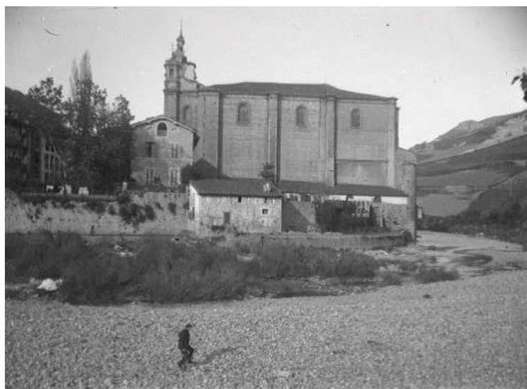
Villa de Tolosa. Iglesia de Santa María, Palacio de Aranburu y molino de arriba (AMT).
