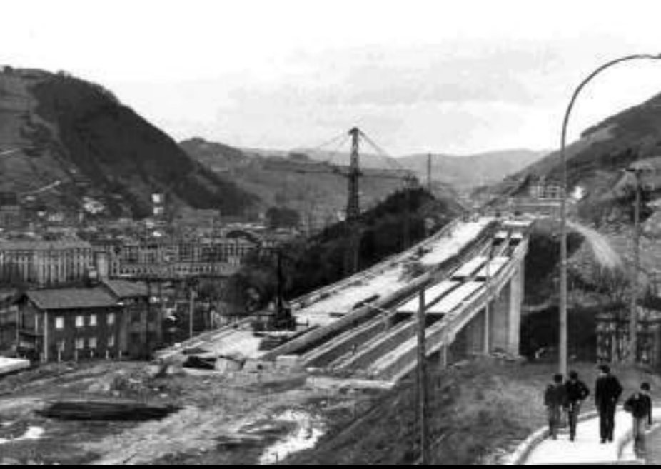
Igarondoko Zubia Viaducto Igarondo
