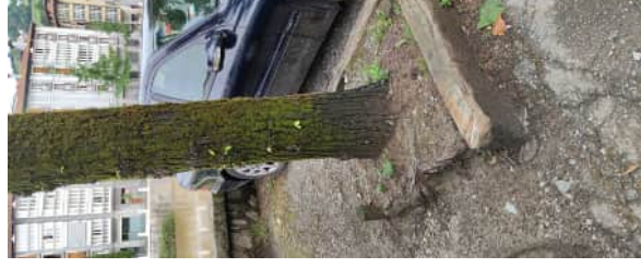
Imágenes : Uno de los pocos alcorques originales,-alcorque en descomposición - raíces espiralizadas y desarrollo bajo el pavimento
