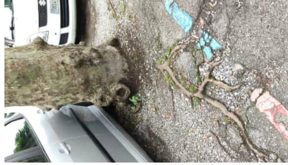
Imágenes : Uno de los pocos alcorques originales,-alcorque en descomposición - raíces espiralizadas y desarrollo bajo el pavimento
